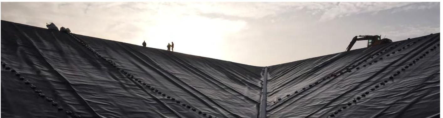
安装带有Solmax耐高温土工膜衬垫的PTES深坑式储热池。
